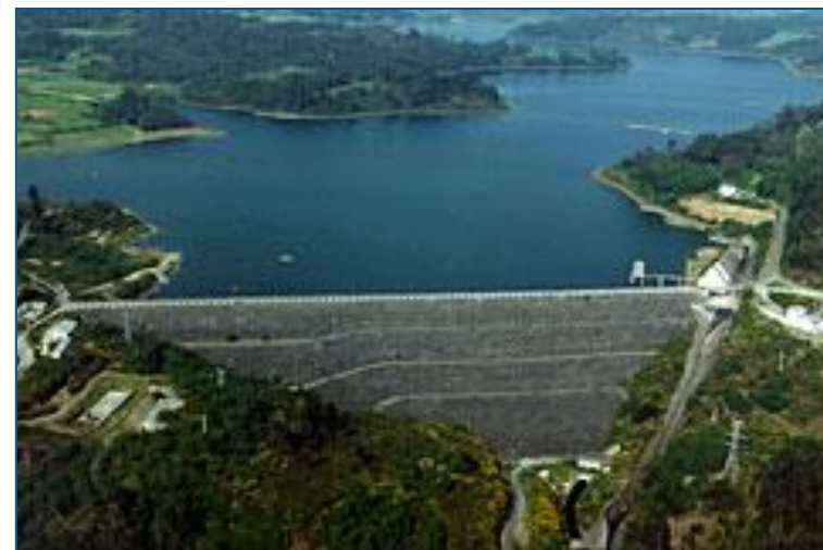
Portomouros 水力発電ダム
