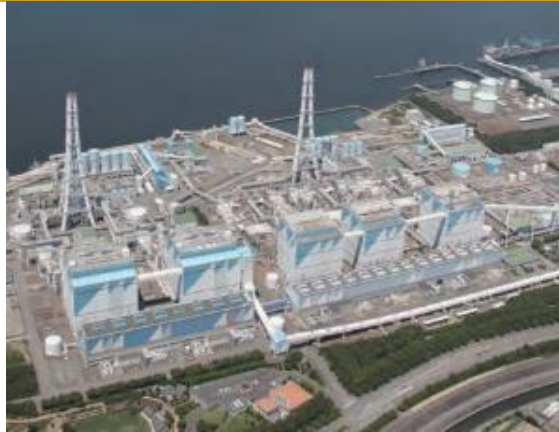
写真提供：株式会社JERA（碧南火力発電所）
